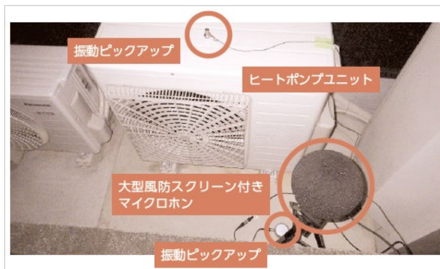
図9 機器近傍（測定地点①）の測定機材の設置例
