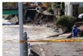
10/13 11:30 栃木県鹿沼市
