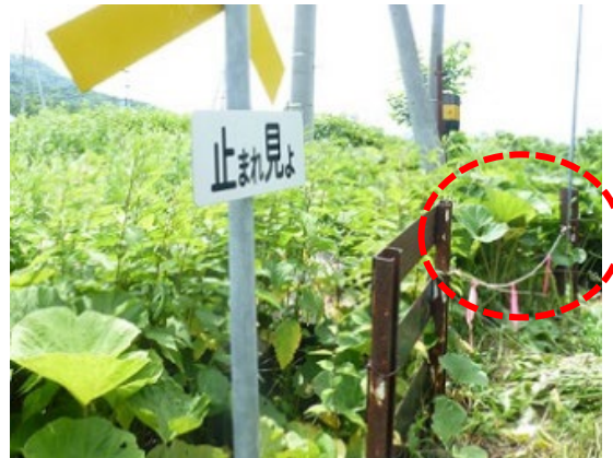
【踏切道に設置されたロープ】
