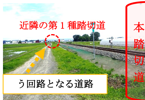
【①の位置から近隣の第 1 種踏切道方向の状況】
