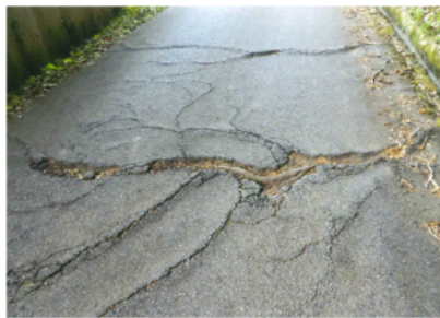
▲木の根が浮き上がり道が凸凹で自転車で通る際に危険！
