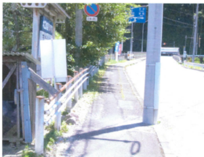
▲県道 309 号沿いの街路樹が伸び、歩行者のじゃまになっているので切ってほしい。
