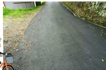
▲市に修繕を要望し、安全に通行できるようになりました。
