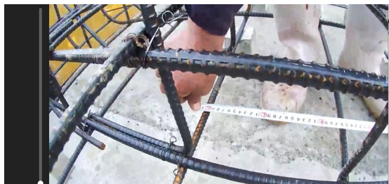
鉄筋の配筋間隔を拡大し検測
