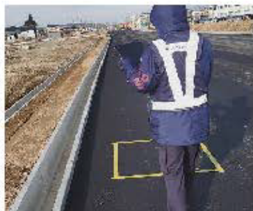
側溝計測
