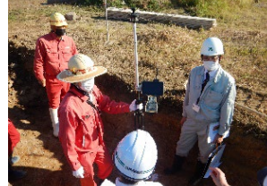
3D設計データ +追尾型TSで 座標・高さ(XYZ座標)の 確認が瞬時に可能！
