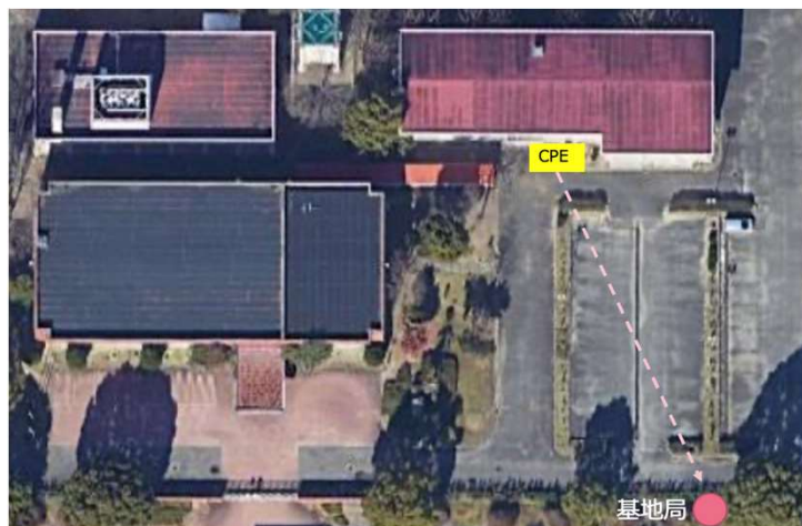
基地局の設置場所①
