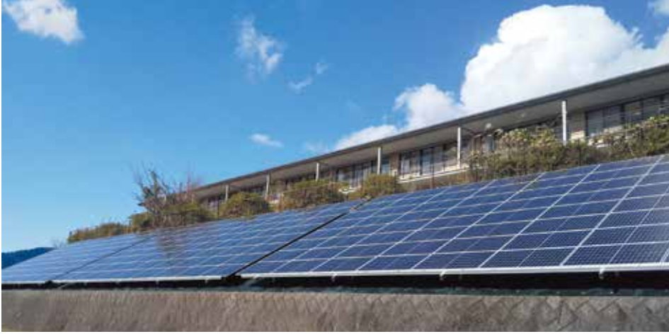
100%の市民出資で、市民エネルギー生駒が設置・運営している太陽光発電。発電した電気は、いこま市民パワーが市内に供給。
