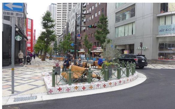
整備後：舗装と休憩スペースが活性化のキモ、それを丁寧にデザインした(神戸市道)
