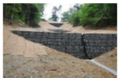
写真3: 多摩森林科学園災害復旧工事
