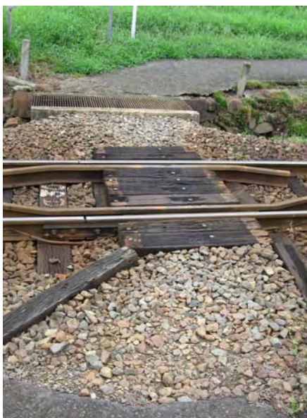
事例9: 畑踏切(広島県内4種踏切、芸備線、上三田駅構内)
