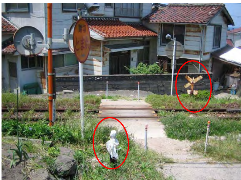
事例11：山城踏切(島根県内4種踏切、山陰本線、波根駅構内)
