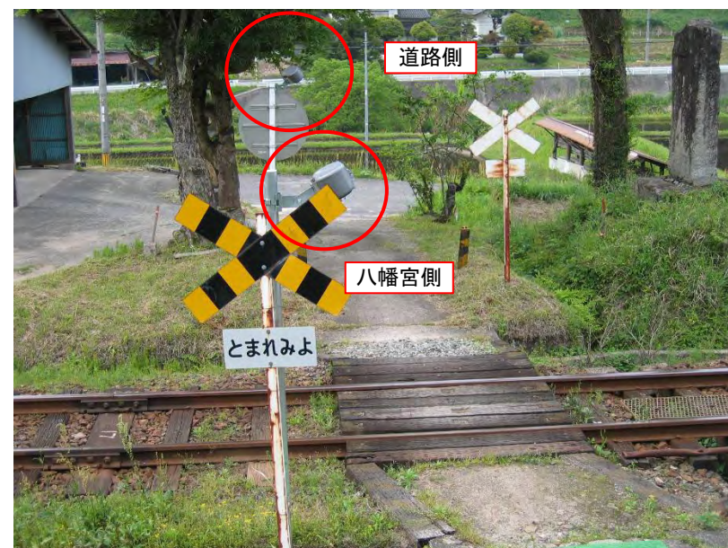
事例14:宮の下踏切(島根県内4種踏切、木次線、下久野駅構内)
