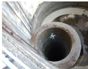
日野谷発電所サージタンクの点検調査状況
