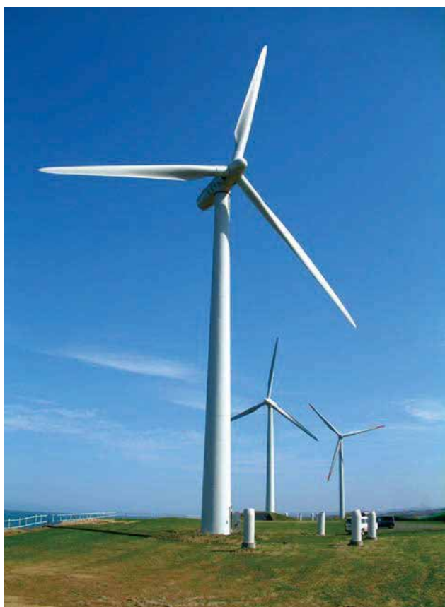
【苫前夕陽ヶ丘風力発電所】
