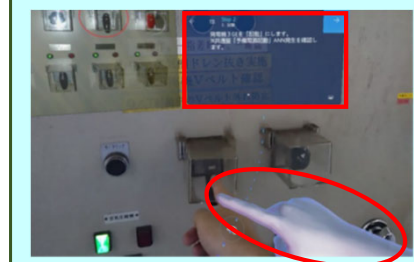
HMDを通して見た設備の操作盤。現実世界（設備）にデジタルコンテンツ（ここでは、作業マニュアル [上の四角枠] と同マニュアルに基づく操作対象を指差す3DCGの手 [下の丸枠]）を重ねて表示している。
