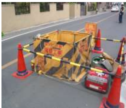
道路規制をかけながらの工事となる場合もあり
