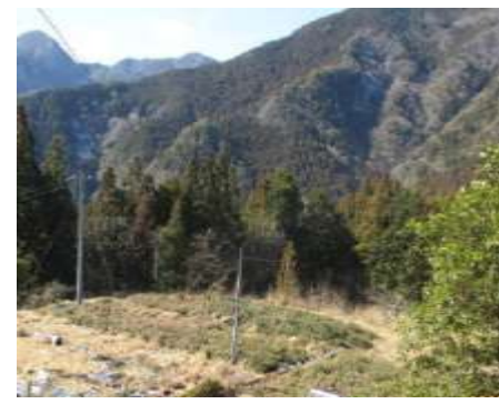
作業車が入れない場所での工事となる場合もあり
