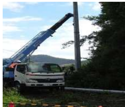
作業車等の重機を用いた工事となる場合もあり
