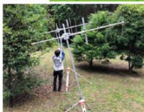
山麓部基地局側に森林内部に向けて八木アンテナを設置
