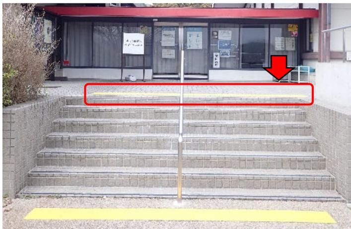
写真2 階段上下付近に設置した点状ブロックの色彩改修の状況
