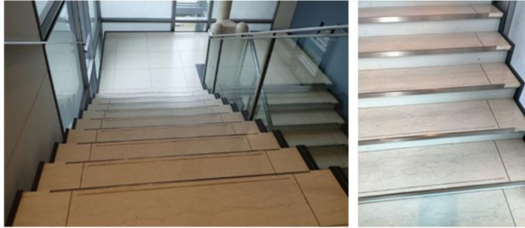
段の端部と周囲が一樣の素材で造られているところ、端部に溝1条が刻まれているほか、端部に厚みのある金属板をはめ込み、端部の視認性に配慮している。
