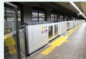
可動式ホーム柵の設置
