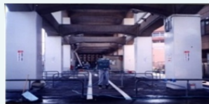
高架橋の耐震対策
