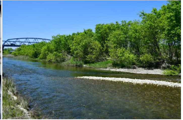
きそがわ 木曾川 (写真提供：愛知県一宮市)
