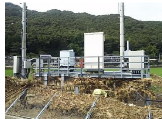
嵩上げによる水没対策
