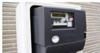
スマートメーター
