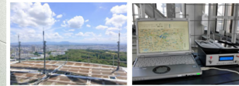
基地側のアンテナ(左)と無線設備、PCモニター(右)
