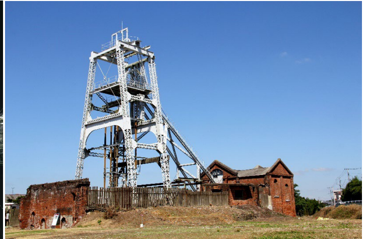
国内最古級の鋼鉄製 櫓 やぐら が残る「宮原坑」 みやのはらこう (写真提供：福岡県大牟田市)
