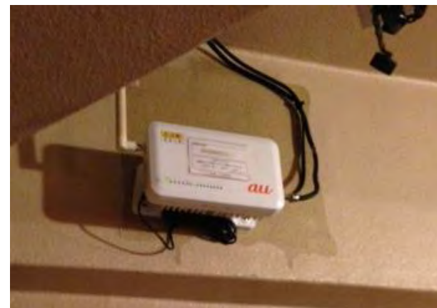
地下の店舗内に設置するレピータ (本体およびサービスアンテナ)
