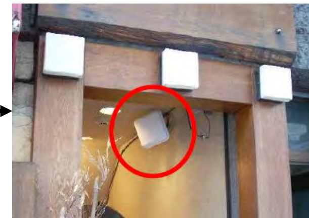
基地局電波を受信するアンテナ (ドナーアンテナ)
