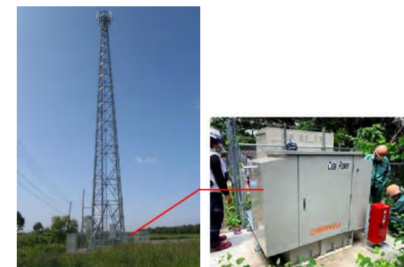
重要エリア基地局の停電対策
