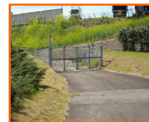
九州自動車道（上り線）緑川PAの例
