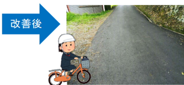
▲市に修繕を要望し、安全に通行できるようになりました。
