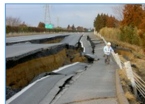
高速道路中継伝送路倒壊
