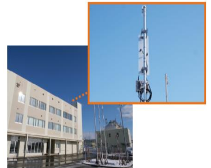
管理棟上の基地局設置風景
