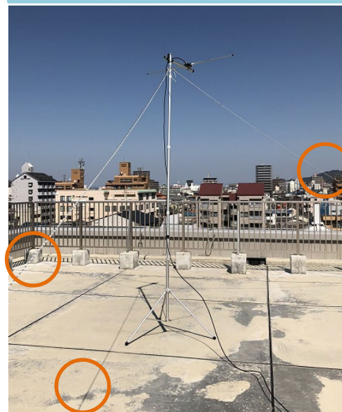
設置例 市役所等の屋上に アンテナ設置する場合
