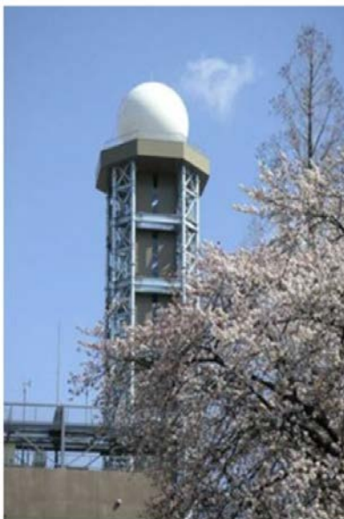
C帯気象レーダーの外観 (気象庁東京レーダー)
