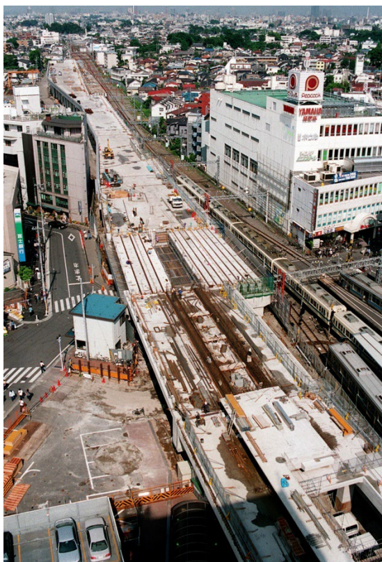
(写真) 複々線化工事が進む小田急線 写真提供：読売新聞社
