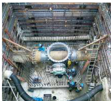
新しい浄水池への送水管の分枝工事
