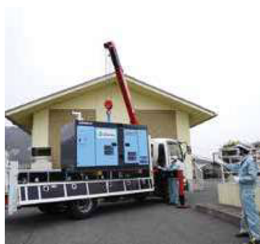
電源車として活用する可搬式発電機と運搬用トラック
