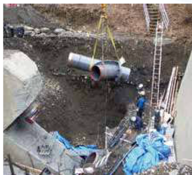
横川蛇石発電所の水圧管据付
