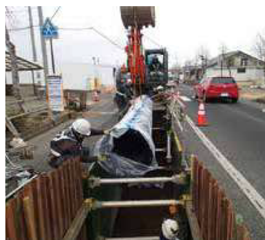
管路の耐震化工事(千曲市杭瀬下地区)
