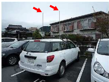
アンテナ設置状況
