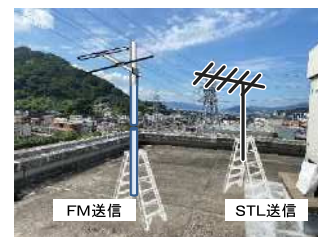
実験用(FM送信、STL送信)アンテナ設置 イメージ
