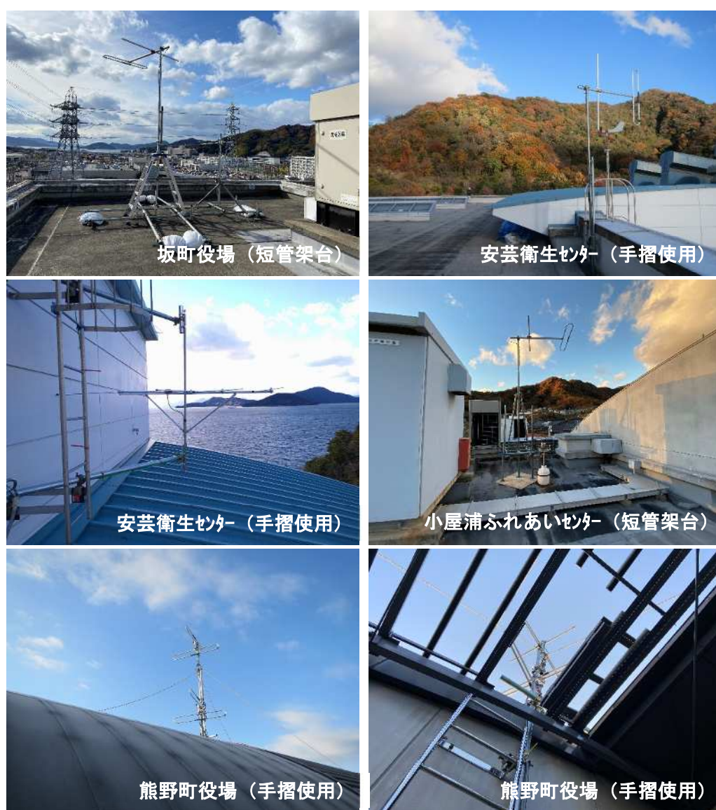
図 4-13 実験局アンテナの設置状況 (その 1)
