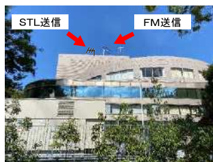
実験用(FM送信、STL送信)アンテナ設置 イメージ
