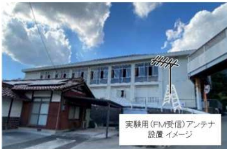
子局 熊野第二小学校 (体育館)
