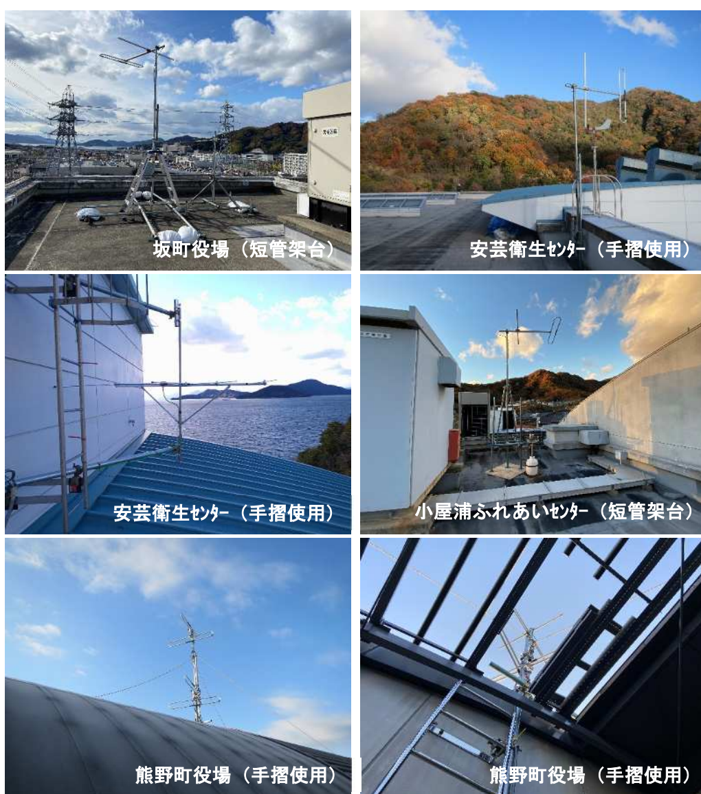
図 4-13 実験局アンテナの設置状況 (その 1)
