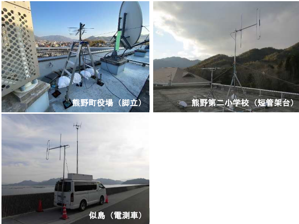
図 4-13 実験局アンテナの設置状況 (その 2)
