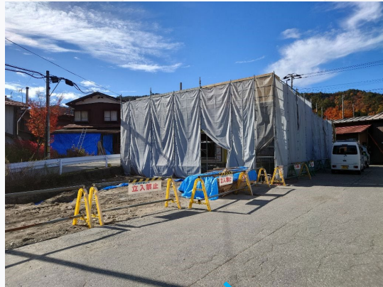
建替え工事中の現地の状況 (R4.11.7現在)
