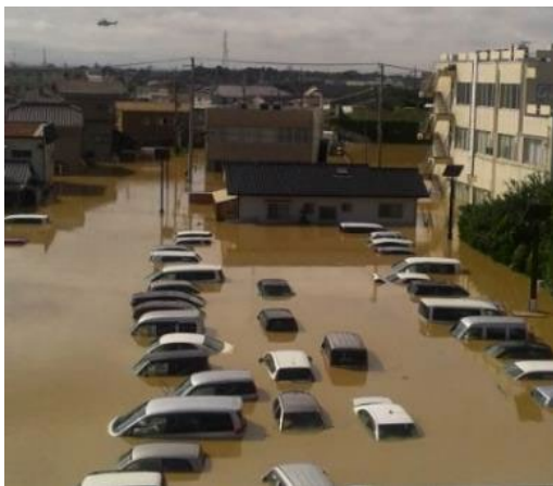
写真 2 2015年9月の関東・東北豪雨で浸水した常総市役所
