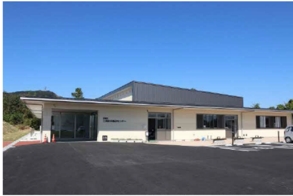
三角防災拠点センター
