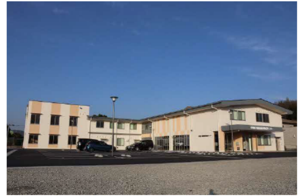
松橋防災拠点センター東
