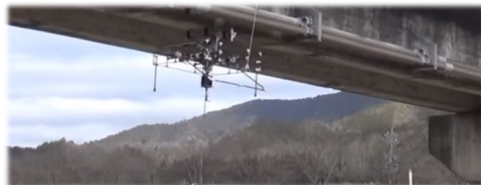
打音検査センサ部を上向き→床版下面の点検実現
