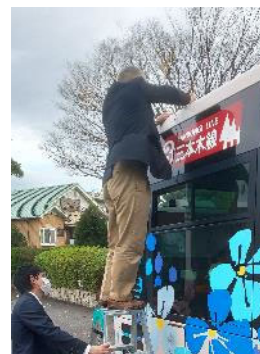
空中線設置作業
