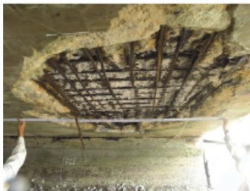
内部の鉄筋が露出した橋梁
