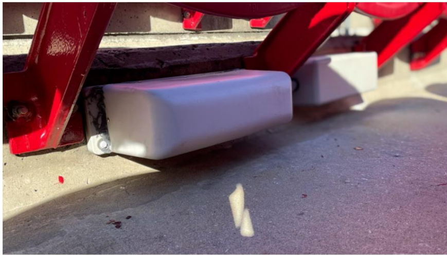
スタジアムのシートの下に設置された5Gミリ波の小セル
