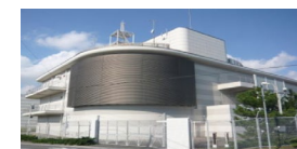
海底ケーブル陸揚局舎等
