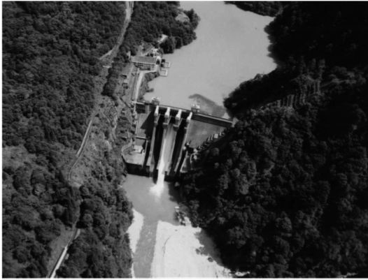
(写真) 排砂中の出し平ダム
