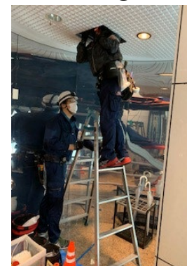
レピータ本体(屋根裏)交換
