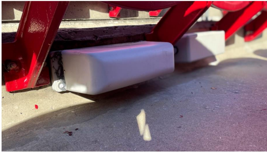
スタジアムのシートの下に設置された5Gミリ波のsmallセル
