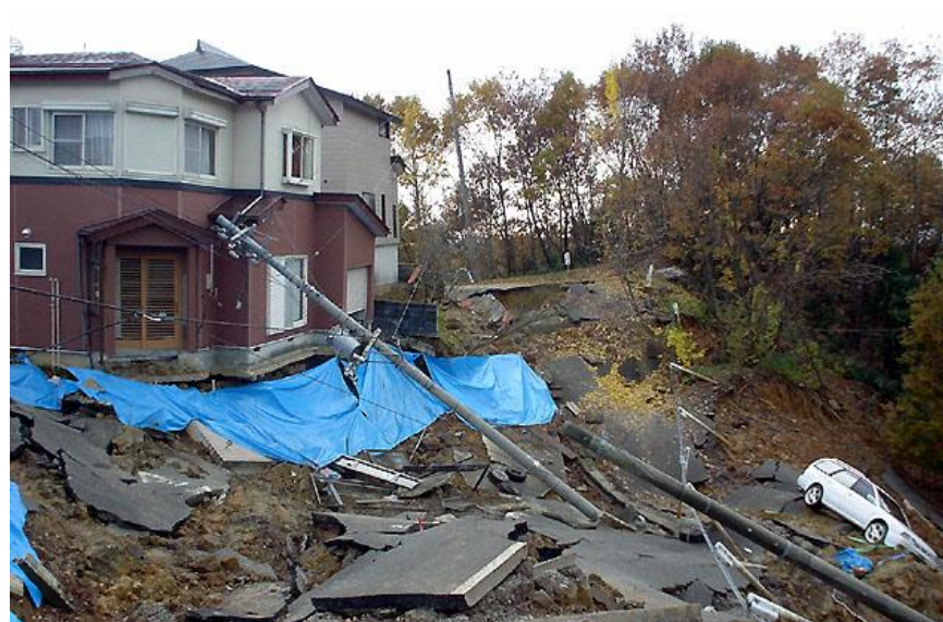
団地の外周道路が大規模に崩落し、住宅が被災
