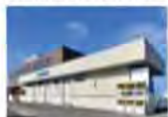
集出荷・貯蔵・加工施設の整備
