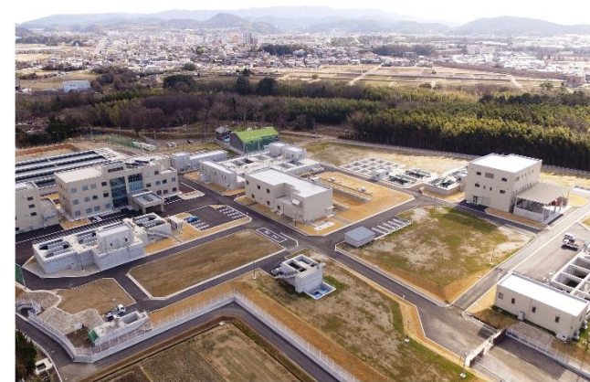
男川浄水場（全景）
