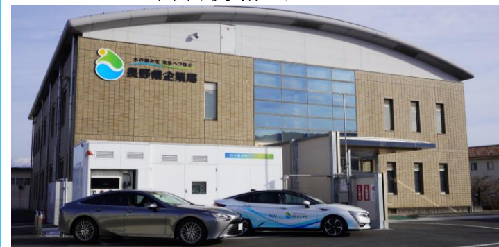
川中島水素ステーション
