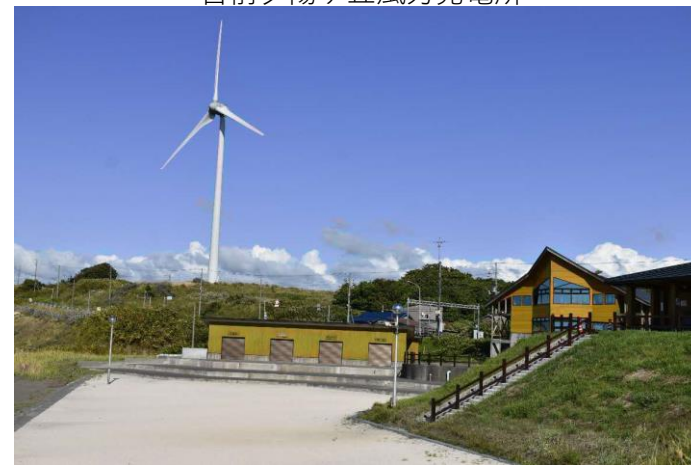
苫前夕陽ヶ丘風力発電所
